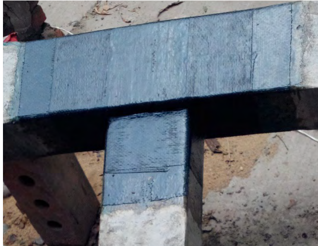
Fig. 4.7: CFRP Fabrics wrapping
