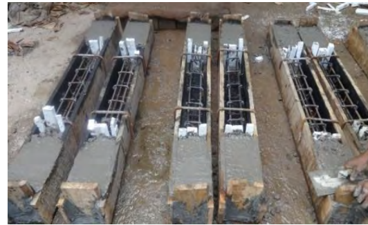
(d) Concrete casting in end lifts first
