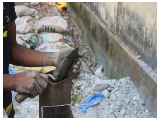
(d) Concrete placement
