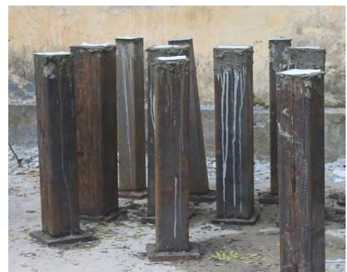
(d) Constructed CFST columns
