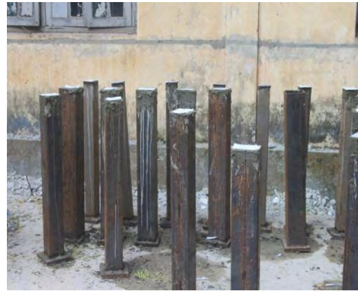
(d) Constructed CFST columns
