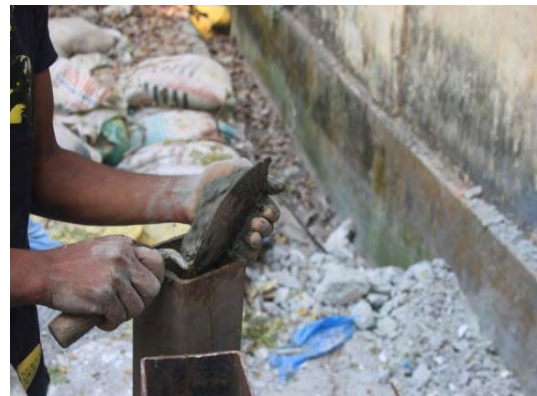
(d) Concrete placement
