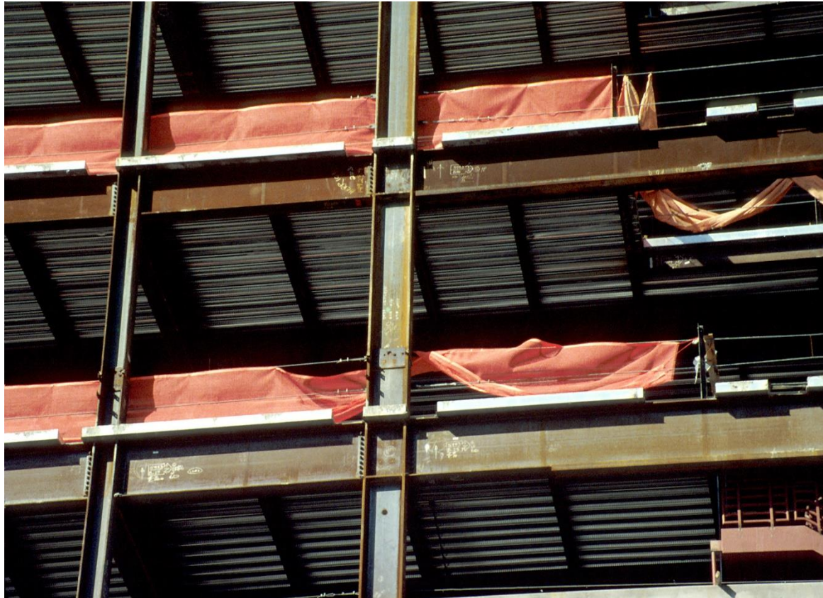
Fig. 2.1: Moment Resisting Frame (MRF) (Engelhardt 2007)
